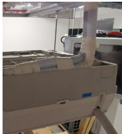
Detail napojení chladivodů a kondenzátu u konvertibilní jednotky
